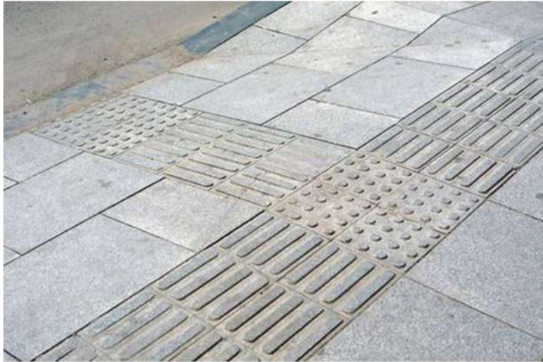
Dale tactile pentru ghidare și orientare nevăzători
