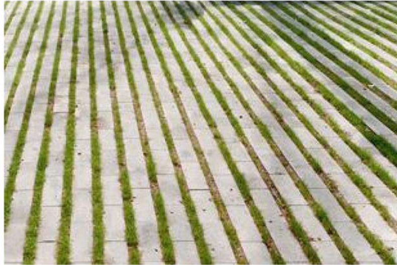
Pavaj din dale piatră înierbate
