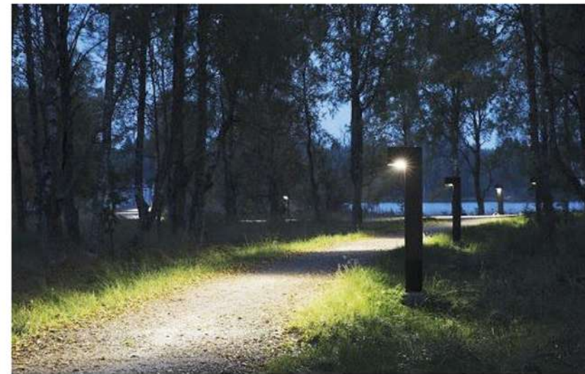
Corpuri de iluminat pietonal
