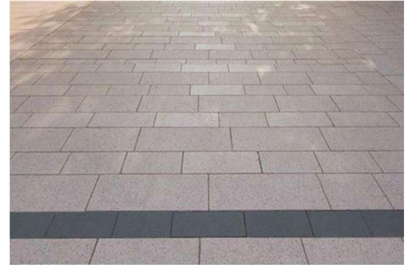
Pavaje din dale piatră andezit
